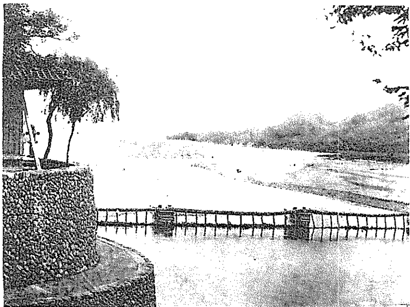
羽村の堰 ここから多摩川の水を取水して江戸に送った(明治初期の写真)
