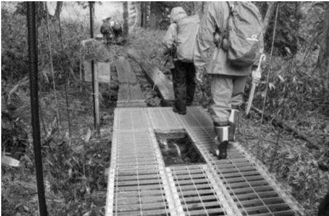
写真 .. 設置された大江湿原入口付近の「シカ侵入防止柵」と「グレーチング」（2014年7月19日 大山昌克氏撮影）
