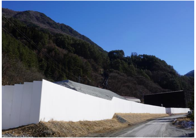
小渋川非常口掘削土仮置き場 (この場所は後に変電所を建設予定)
