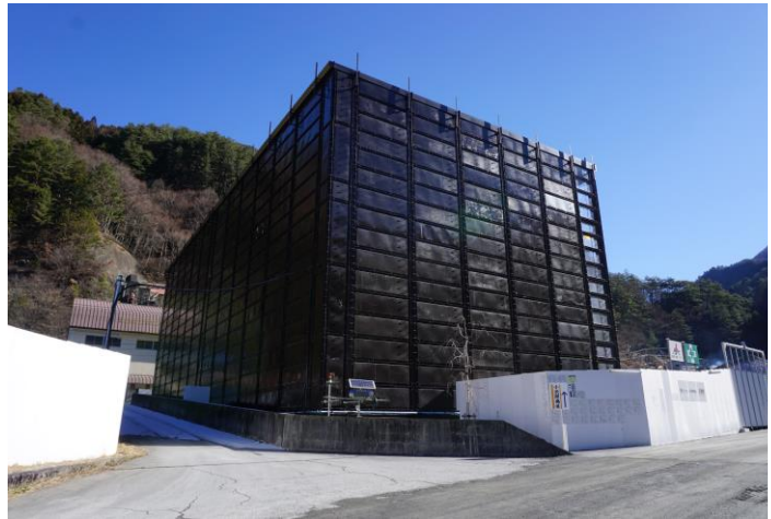
小渋川非常口掘削現場の防音ハウス
