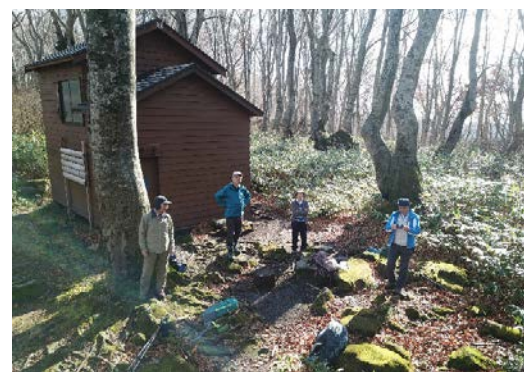
鶴間池避難小屋
