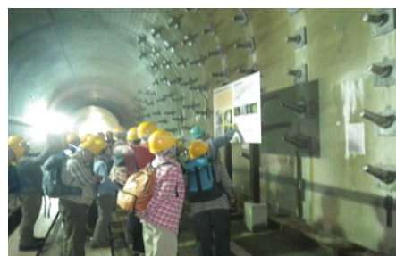
崩落防止ワヤ-内側
