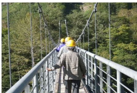
白岩堰堤上の作業橋
