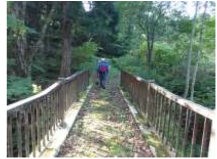
沢に架かる橋
