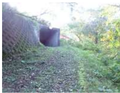
国道下トンネル
