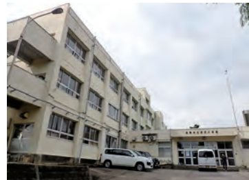
深沢小学校舎
